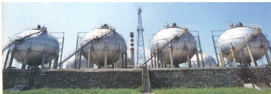
图 6：固定式压力容器（球形储罐）
